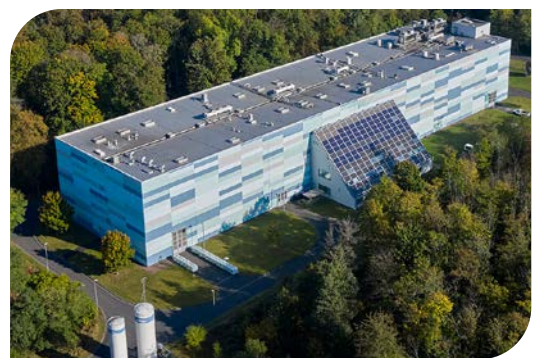
Abb. 1: Das Wasserwerk Aschaffenburg
